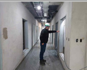
공사현장 안전전담 인력 순회점검
