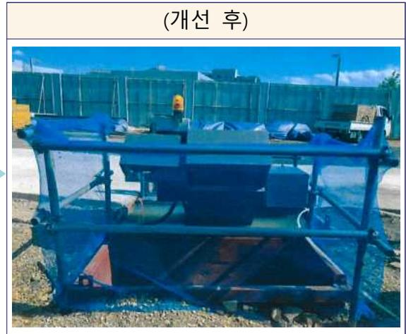
○ 가설전기 분전반 표지(접근금지, 관리책임자, 경고표지) 미부착 및 안전휀스 설치
